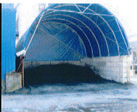
Overdekte opslag granulaat
