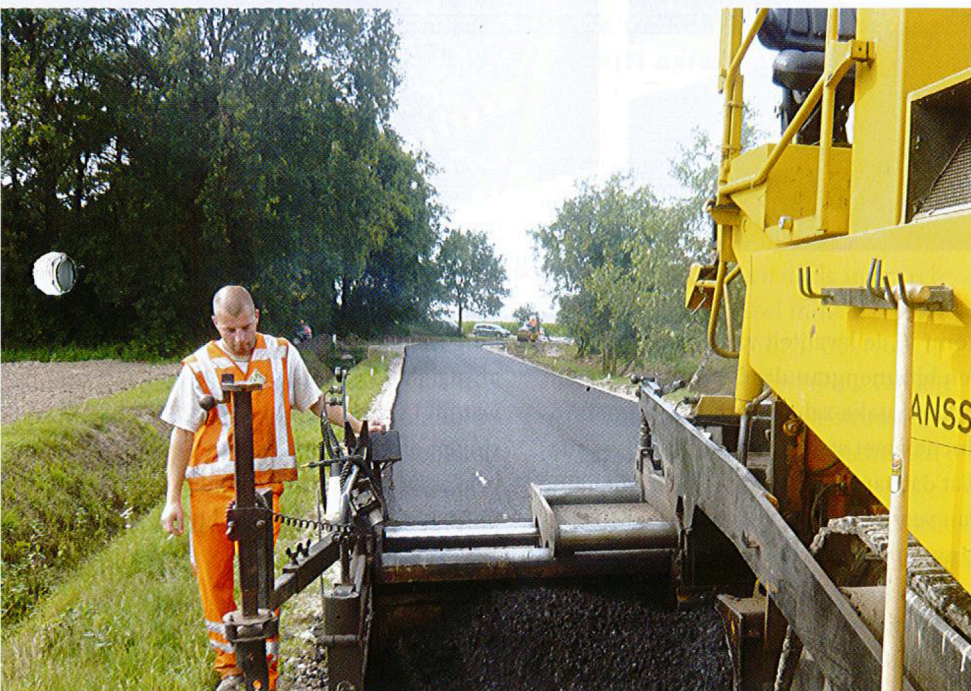
Aanbrengen onderlaag is net als traditioneel asfalt
